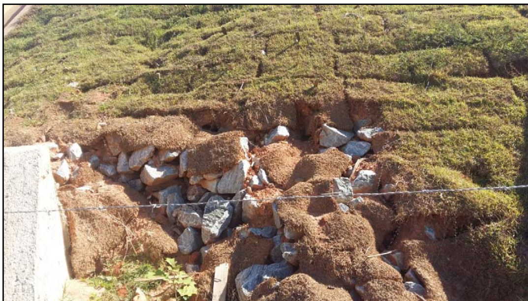
Foto 5: Região da boca de jusante do bueiro celular BSCC 3,00 x 3,00 m mostrando a camada de empedramento parcialmente encoberta pela vegetação de proteção da saia do aterro.
