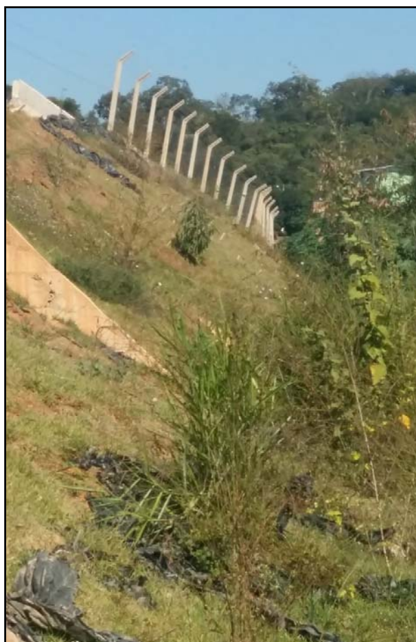
Foto 6: Vista da cerca /alambrado deformada pelo recalque do aterro de encabeçamento já um pouco mais afastado do viaduto.
