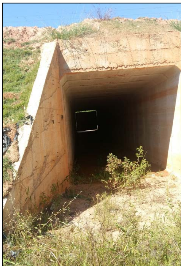
Foto 7: Vista do bueiro celular (3,00 x 3,00) m, da boca de jusante para montante. Aparentemente não houve recalque diferencial das aduelas pré-moldadas.
