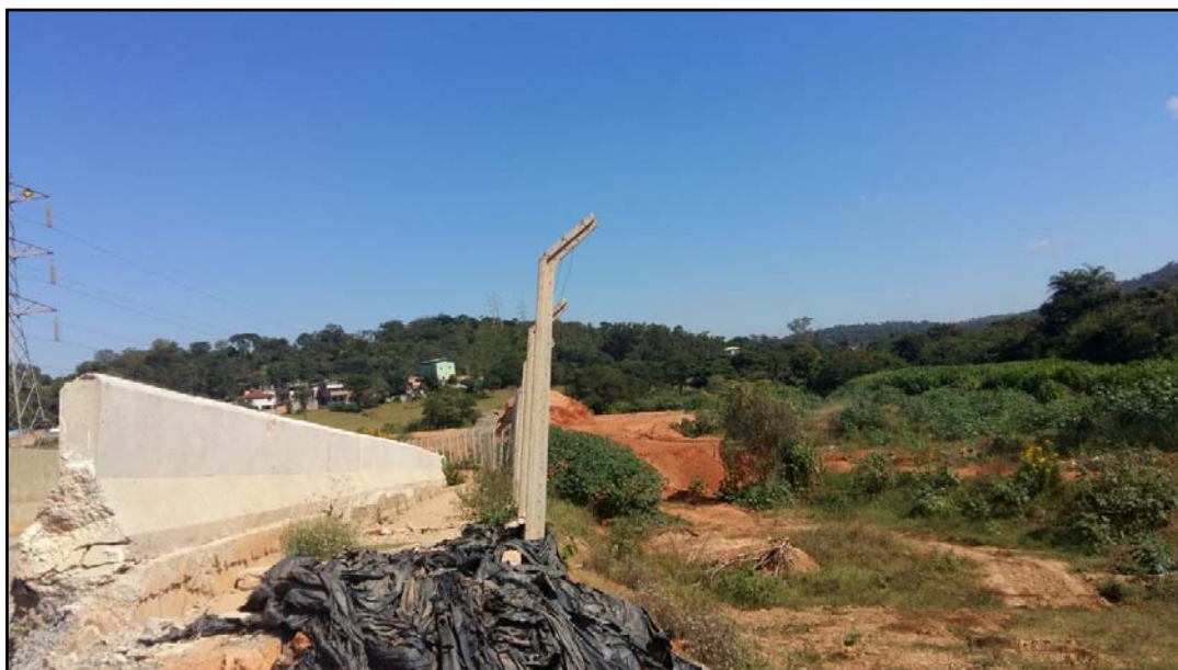
Foto 12: Vista do recalque do passeio entre a barreira New Jersey e o alambrado, ao fundo o local de bota espera do material oriundo do aterro removido apenas parcialmente.
