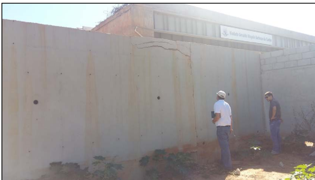
Foto 3: Danos causados no topo do muro M 01 por recalque e esmagamento no encontro do topo do M 01 com o M02.
