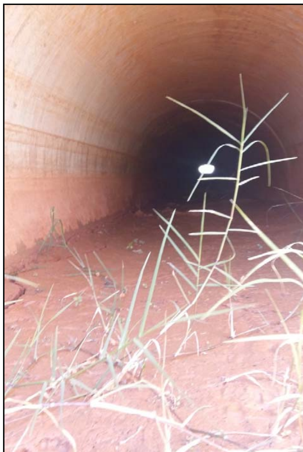
Foto 9: Vista da boca de jusante pra montante de bueiro tubular de concreto BSTC Ø 1,00 m com assoreamento parcial, com pequeno selamento próximo ao eixo do mesmo.
