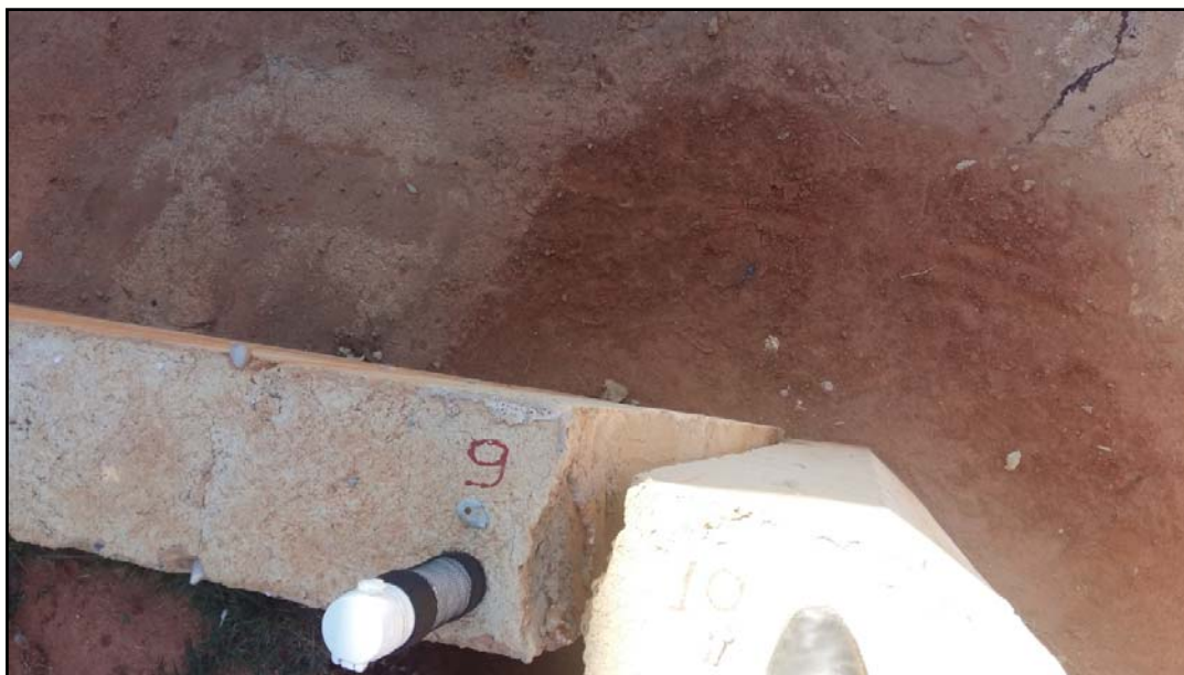
Foto 4: Ilustração da movimentação dos muros M 01 e M 03 de contenção do aterro de encabeçamento do Viaduto Geraldo Magela Barbosa da Cunha.
