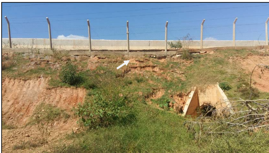
Foto 8: Recalque da saia do aterro na região do alambrado e boca de jusante do outro bueiro tubular de concreto BSTC Ø 1,00 m.
