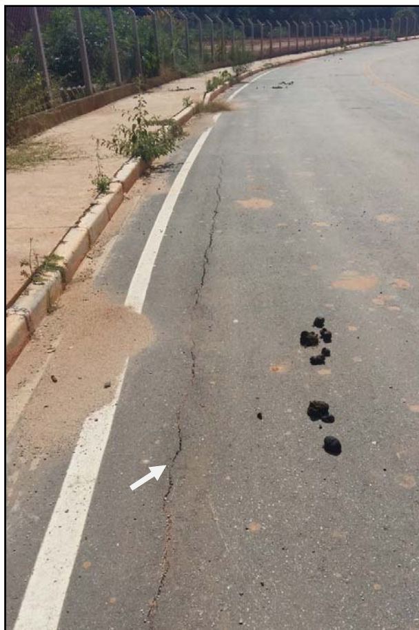
Foto 11: Trinca no bordo da pista de rolamento causada pelo recalque do aterro na região do alambrado.
